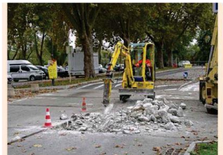
COUP DE NEUF SUR LA CHAUSSÉE > Un passage affaissé de l'avenue de Lahr a été refait cette semaine, provoquant un changement temporaire dans la circulation, jusqu'à ce que soit posé un nouvel enrobé.
